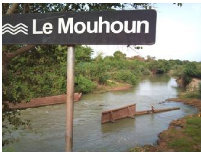
Photo : Point de déviation des eaux du fleuve Mouhoun dans le fleuve Sourou (Crédit : J-C Frisque)
