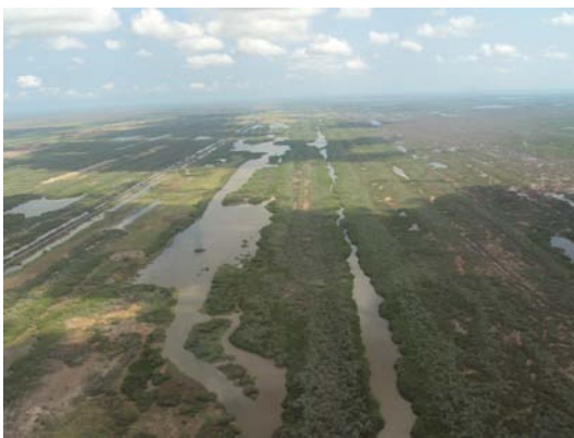
Construcción de canales
