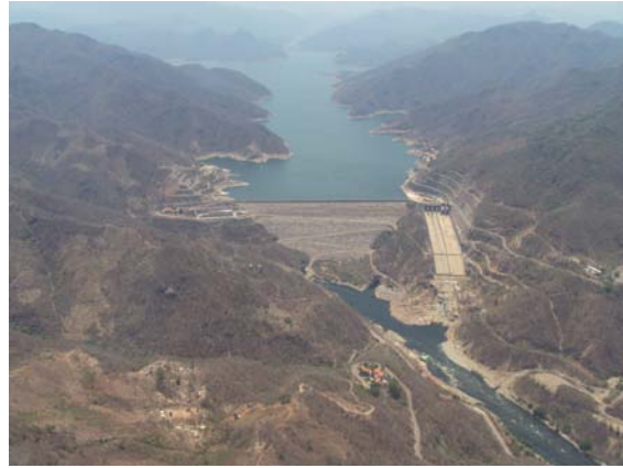
Presa Agua Milpa
