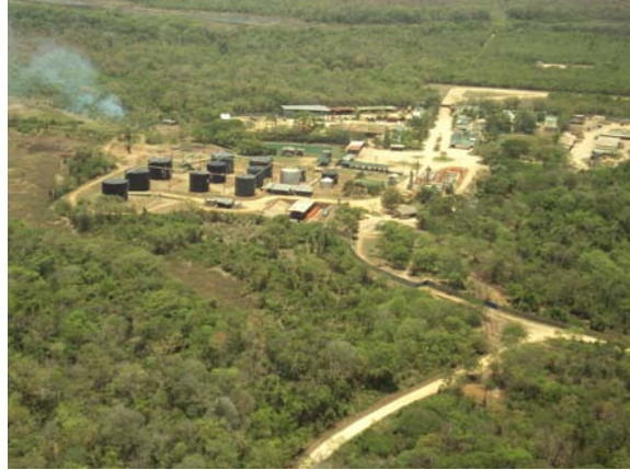
Instalaciones de Perenco
