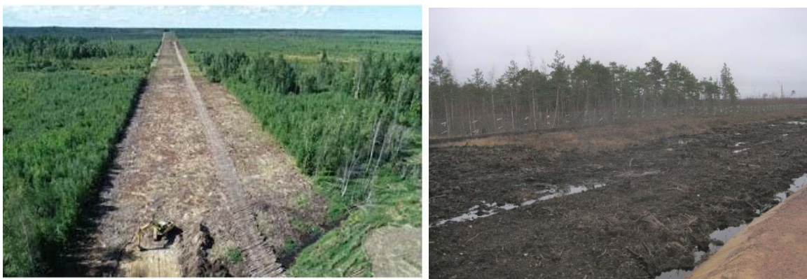
Рис. 12. Рабочий коридор с уложенными послойно бревнами (слева) и после демонтажа (справа)
