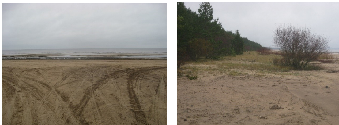
Рис. 5. а) Вид на запад от коридора строительства до места, где во время прокладки трубопровода был установлен волнолом. б) Вид на юг вдоль края коридора строительства (видна высота прибрежных дюн и растительность).
