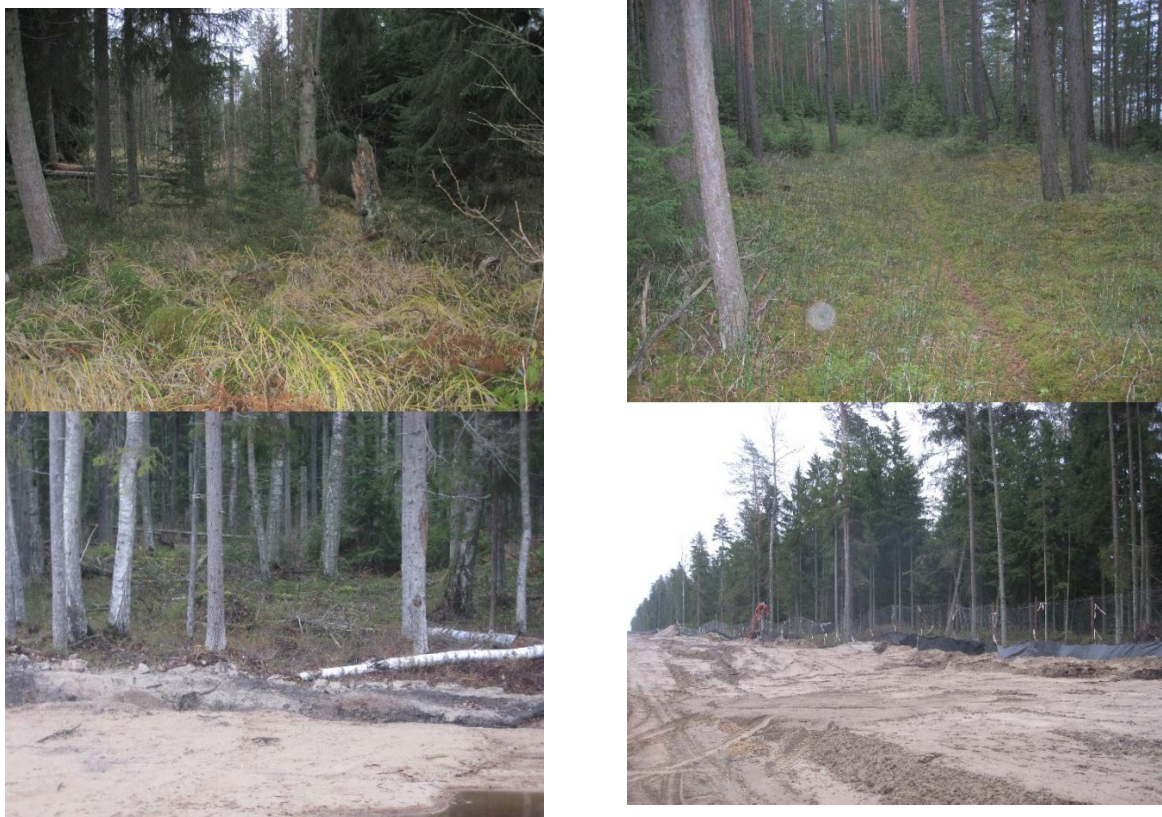
Рис. 6. Вверху слева: пример сосняка хвощево-зеленомошного до начала строительства. Вверху справа: пример ельника чернично-зеленомошного до начала строительства. Внизу слева: холмистый рельеф почвообразующих морских песков в КС. Внизу справа: неглубоко залегающий органический слой, покрывающий почвообразующие морские пески, который виден на краю КС.
