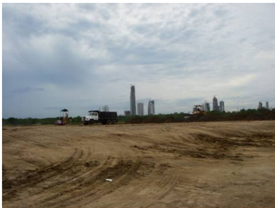
Bahía de Panamá, trabajos de relleno y drenaje de urbanización Sta. María, al fondo Costa del Este. Foto: M.Carbonell
