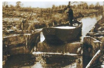
Figura 5b: Compuerta basculante (Klappstau) en el noroeste de Alemania, con un vertedero totalmente transitable y flexible.
