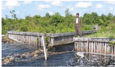
**Figure 5a** : Barrages-seuils en caissons avec grand déversoir, parc national de Sebangau, Kalimantan-Central. Photo ©Wim Giesen.
