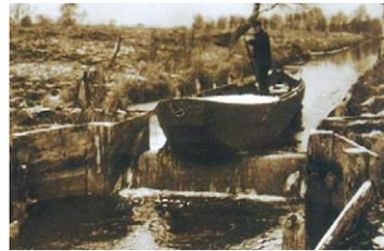
**Figure 5b** : Barrage à clapet (Klappstau) dans le nord-ouest de l'Allemagne avec un barrage flexible entièrement praticable.
