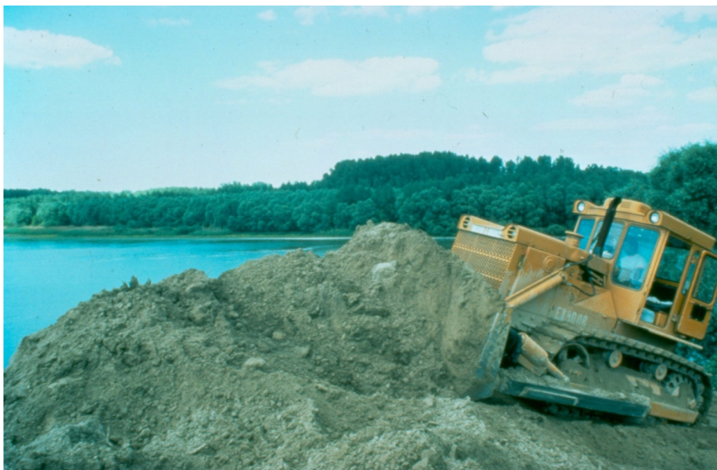
Строительство плотины в Венгрии. Чтобы предотвратить серьезный ущерб водно-болотным угодьям, надо полностью осознавать возможные последствия таких работ. Фото: WWF/Н. Jungius.
